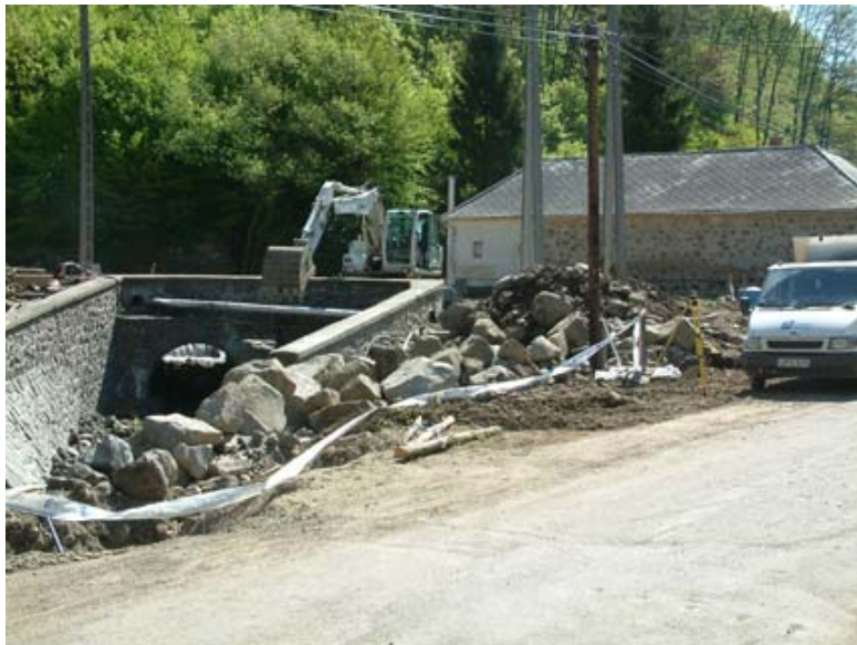
1. ábra: A katasztrófát okozó szűk keresztmetszetű áteresz Mátrakeresztesen, két héttel a 2005-ös árvíz után (Saját felvétel)
