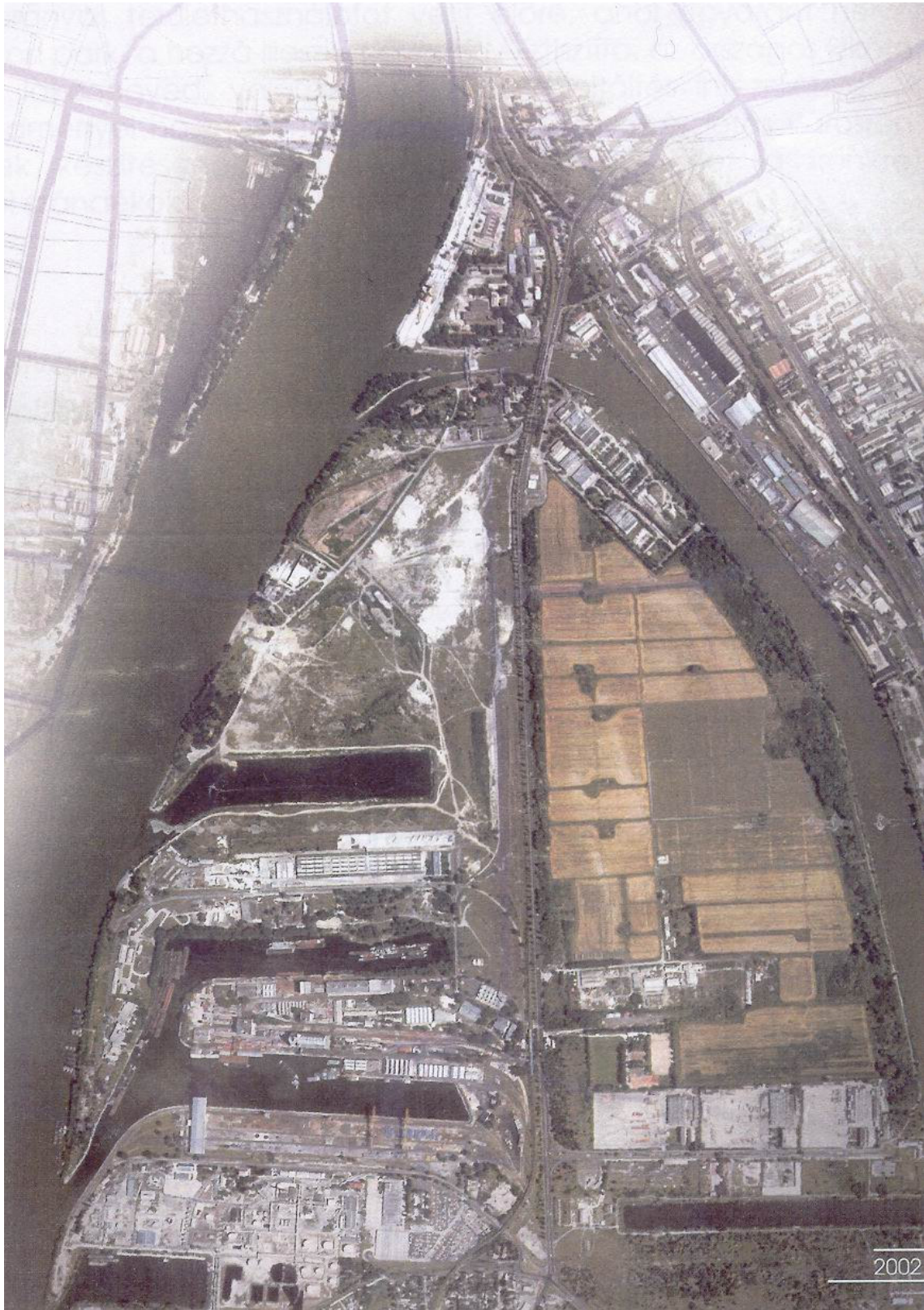
1. ábra. Csepel-északi szigetcsúcs jelenlegi képe (légifelvétel)
